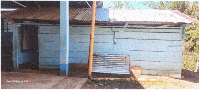
Foto1: MODULO 1: SUSTITUCION DE TECHO
