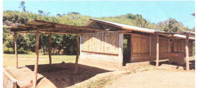
Foto 4: MODULA 2 SUSTITUCION DE TECHO Y PARED
