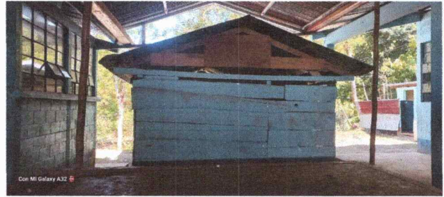
Foto 2: SUSTITUCION DE PARED Y PISO
