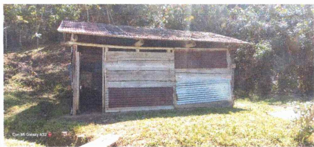
Foto 5: MODULO 3 SUSTITUCION TECHO
